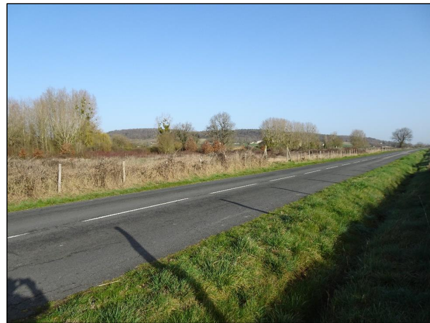
Photographie de l'état initial
