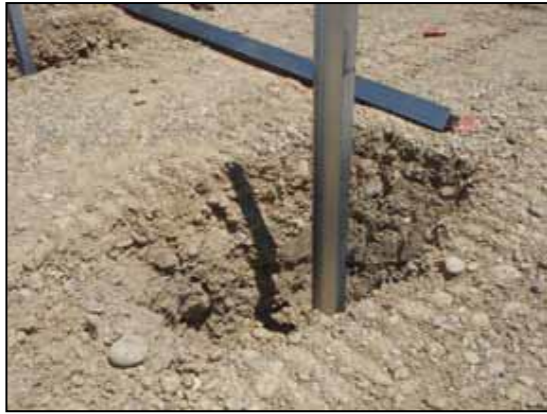
Figure 14 : Types de fondation - pieux battus (Source : Guide MEDDTL 2011 – NCA, 2015)
