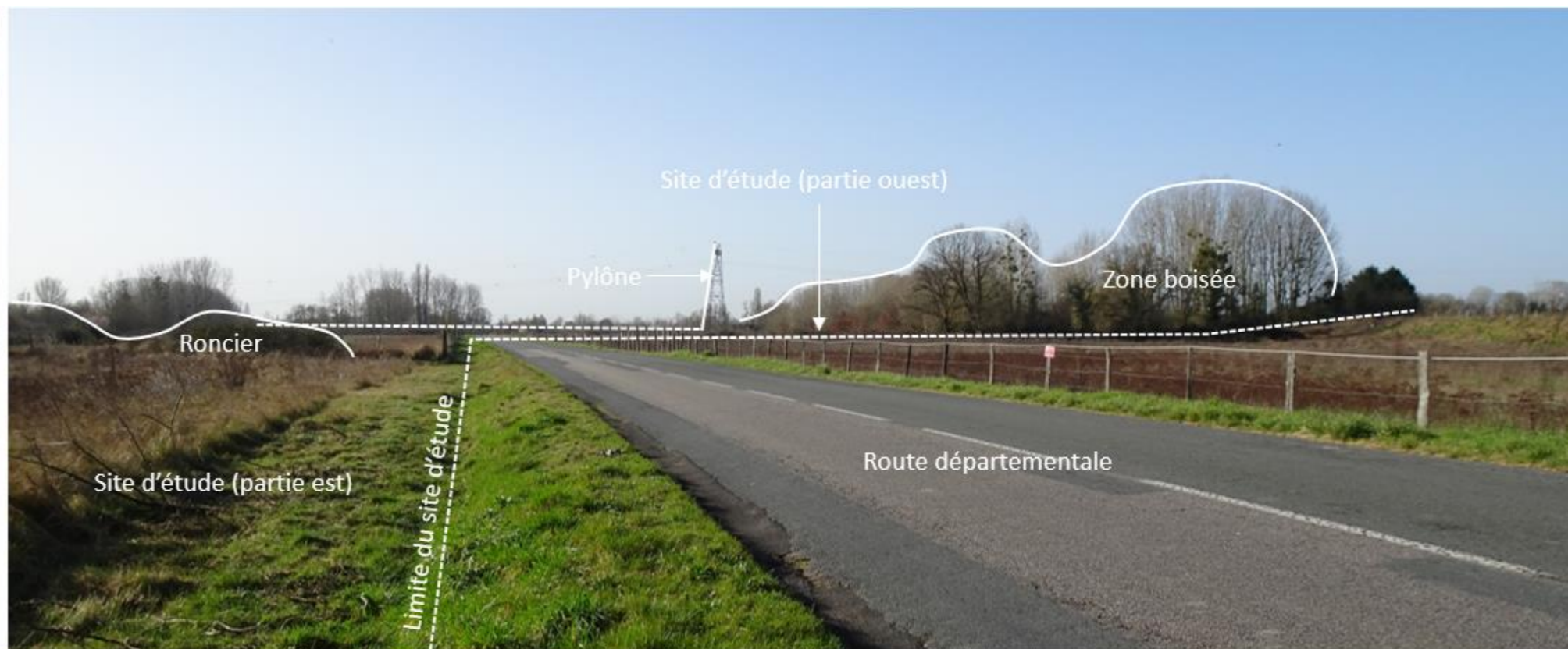
Figure 185 : Photographie des limites des deux parties du site d'étude (Crédit photo : NCA Environnement)
