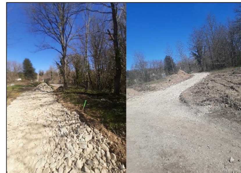
Figure 18 : Mise en place des pistes lors d'un chantier photovoltaïque (Source : TECHNIQUE SOLAIRE)
