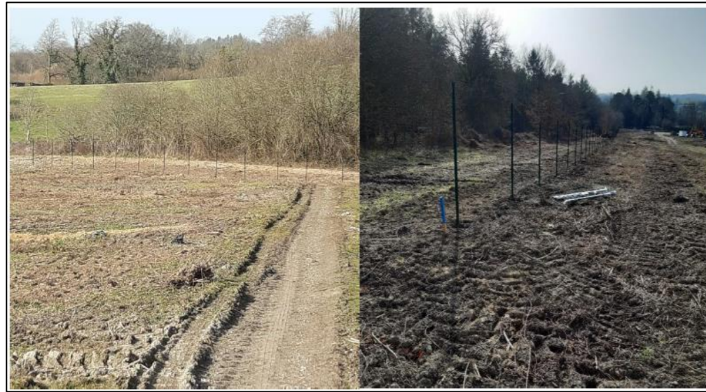
Figure 19 : Exemple de pose de clôture lors d'un chantier photovoltaïque (Source : TECHNIQUE SOLAIRE)
