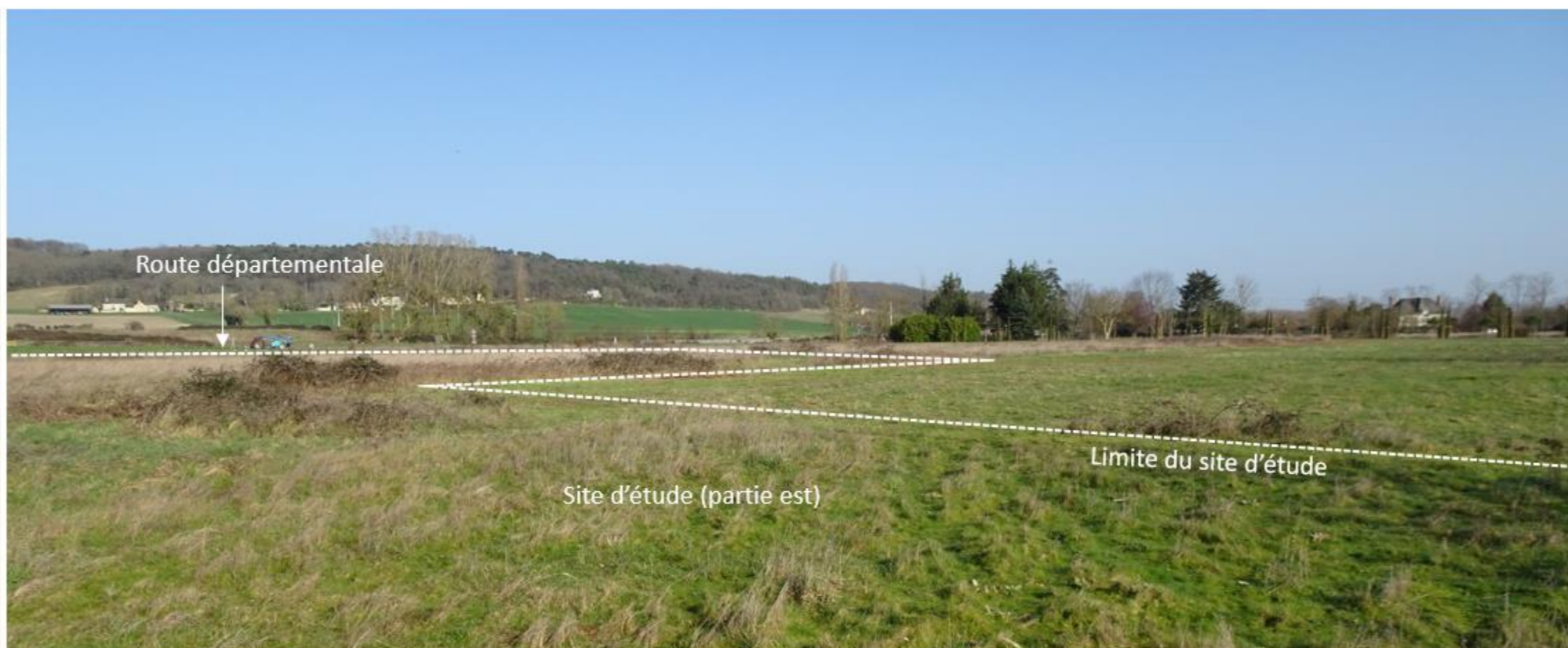
Figure 184 : Photographie des limites nord et ouest de la partie est du site d'étude (Crédit photo : NCA Environnement)
